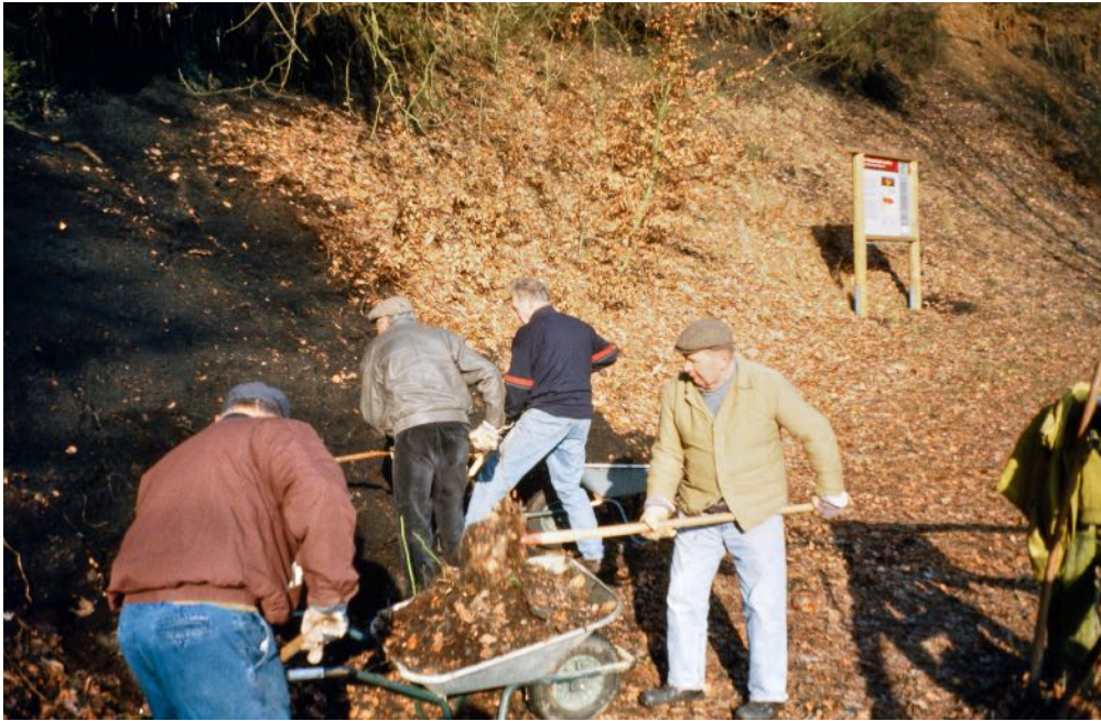
Säuberungsarbeiten an der Schwarzkreidegrube
