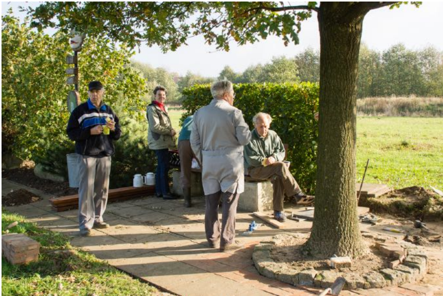
Pflasterarbeiten an der Friedenseiche
