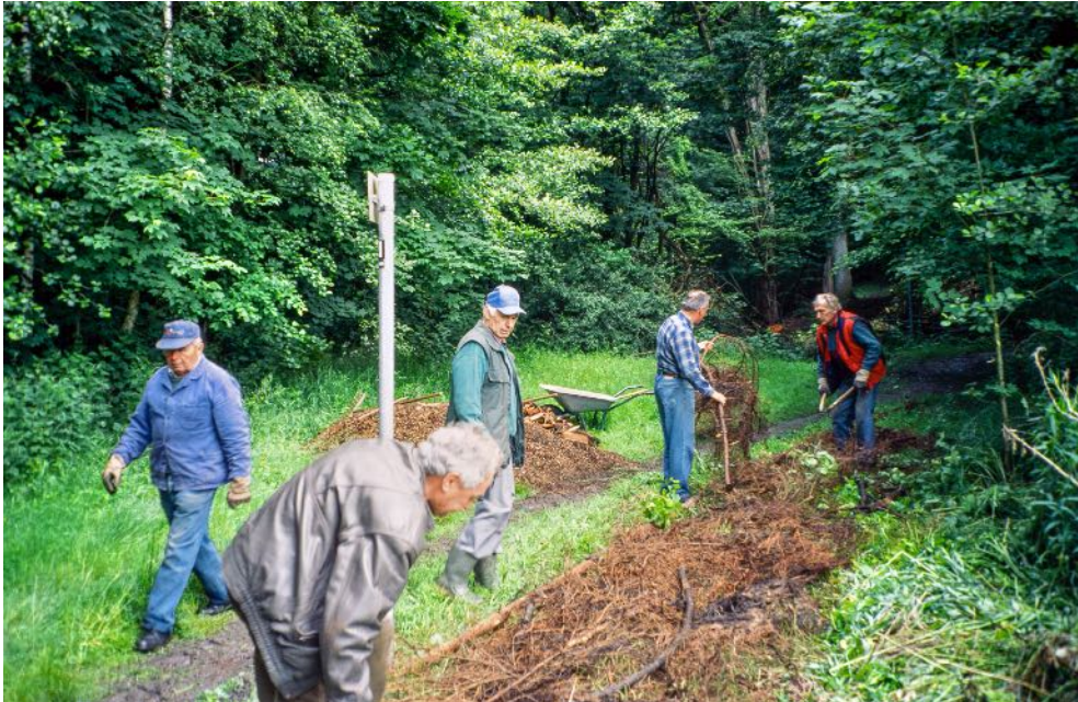
Hier wird ein besonders feuchtes Teilstück des Wittekindsweges unter Anleitung des Wegewartes Adolf Wrampelmeyer trockengelegt und befestigt
